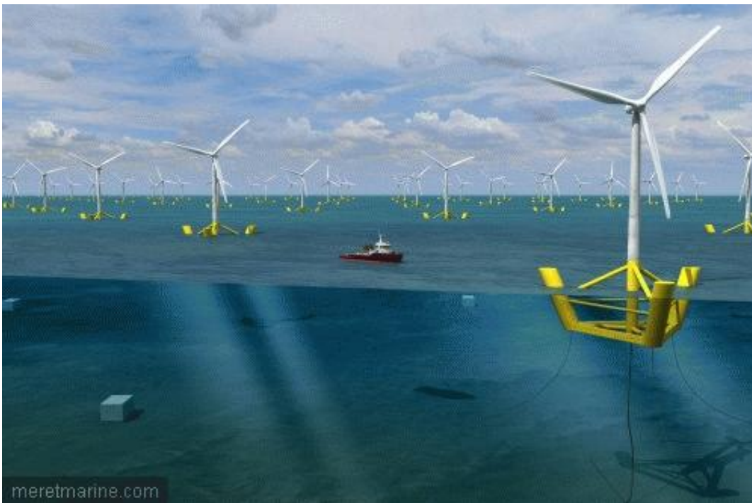
Eolien flottant (© : DCNS)
