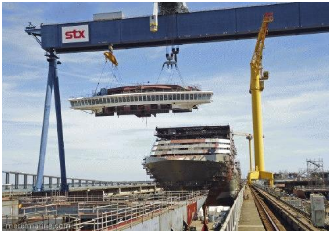
Paquebot en construction à Saint-Nazaire (© : STX FRANCE - BERNARD BIGER)
