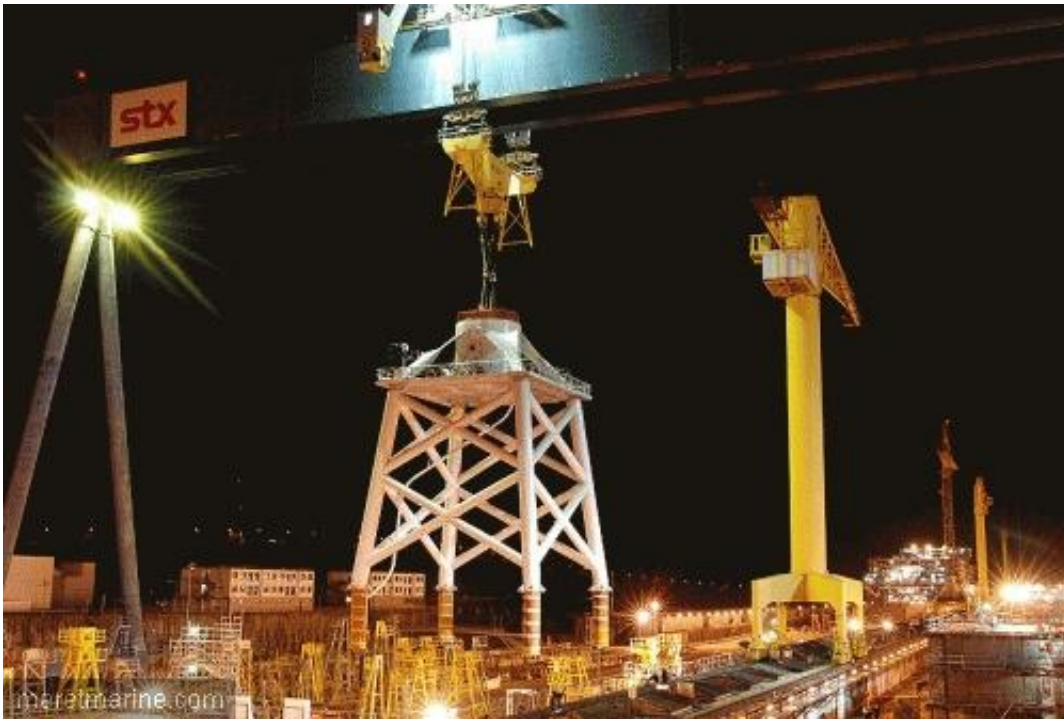
Fondation d'éolienne offshore (© : STX FRANCE - BERNARD BIGER)
