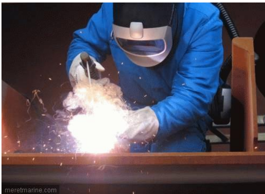
Soudeur dans un chantier naval (© : MER ET MARINE - VINCENT GROIZELEAU)
